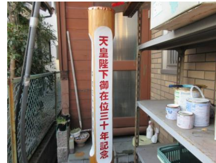
銅葺き防腐塗装で処理
