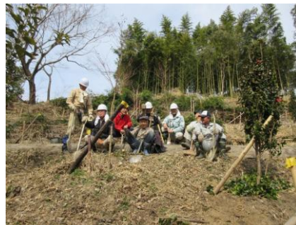
竹林を除去、植栽作業(落葉樹)
